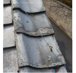
瓦が著しく破損している例
