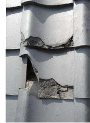
瓦が著しく破損している例
